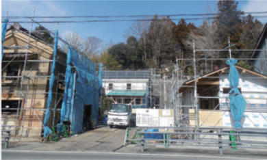
▲工事が進む「三春北町蔵」(仮称)
