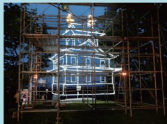
足場を組んだ後にLEDを設置
